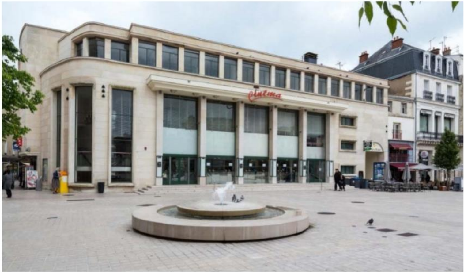
Vue de la façade principale en 2013 – Cliché Laurent Prysmicki
